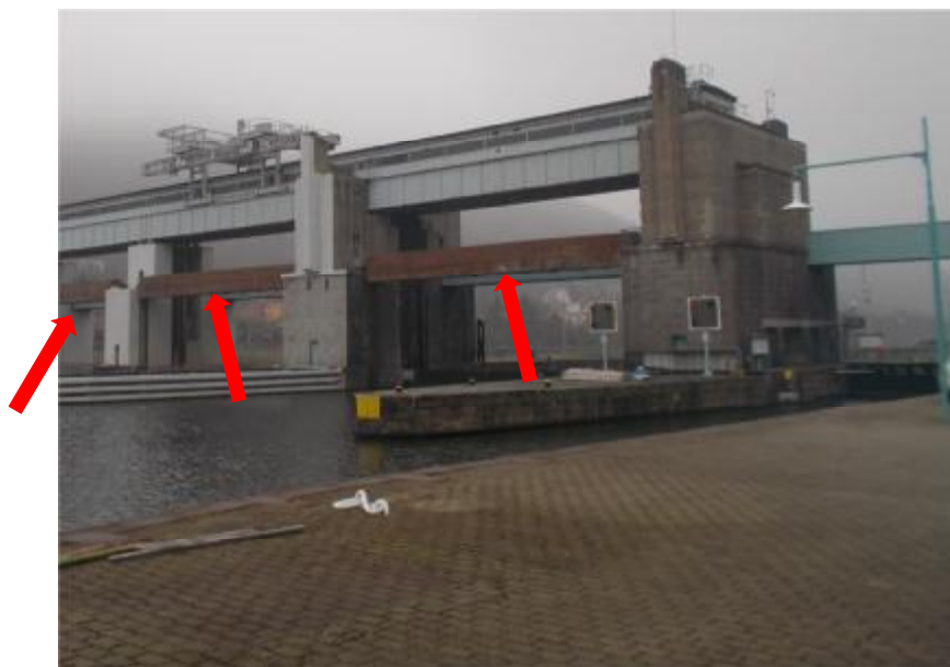
Pohled na umístění hradidel horního provizorního hrazení
