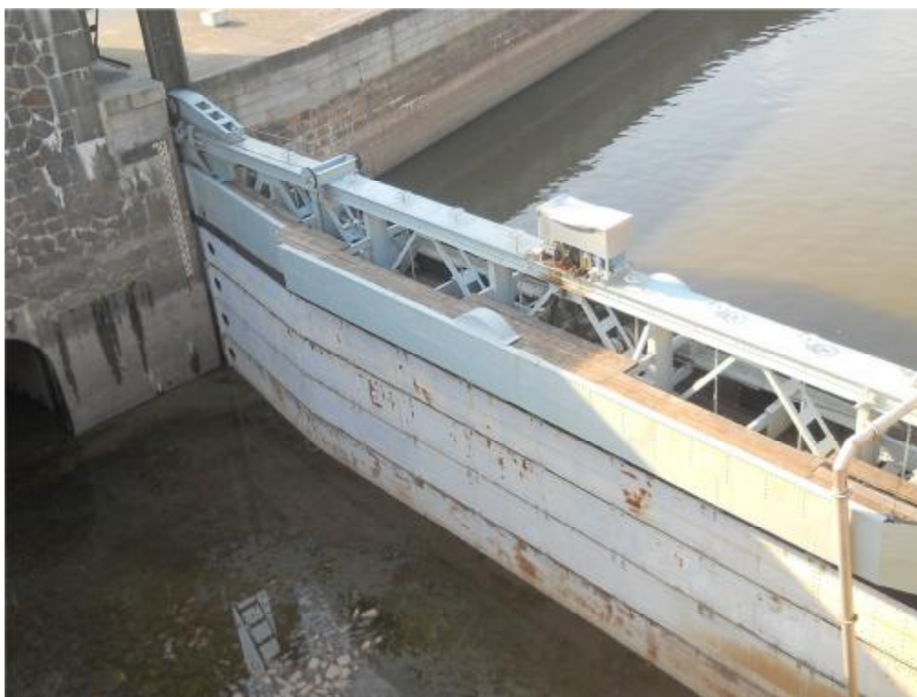
DPH osazené v dolním ohlavi VPK (2012) – hrazená výška 5 m
