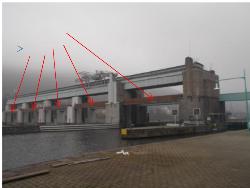
Umístění hradidel HPH na pilířích jezu
